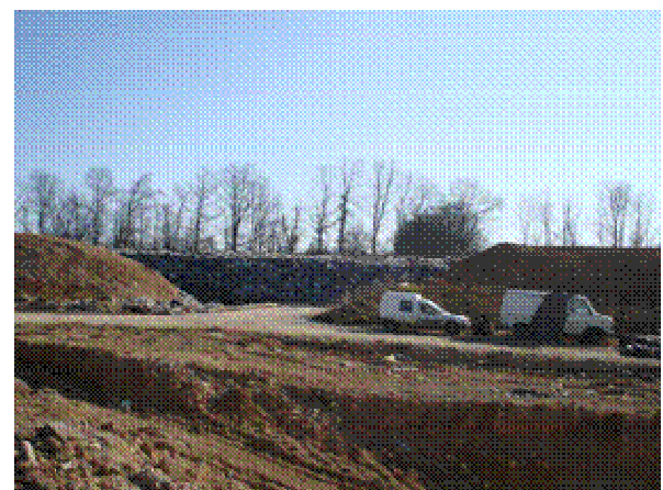
Février 2008 : 2e digue montée (+2,5m)
