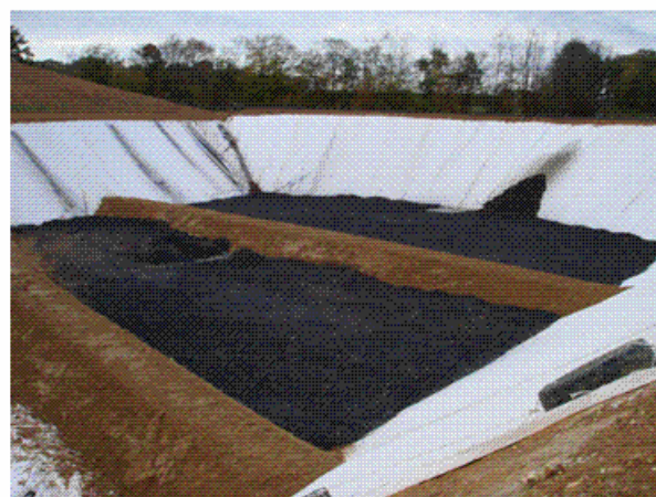
Mise en place du drainant
