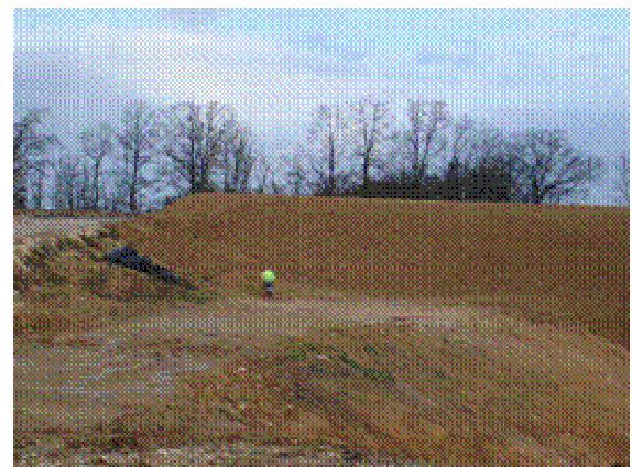
Décembre 2008 : 3e digue montée (+2,5m)
