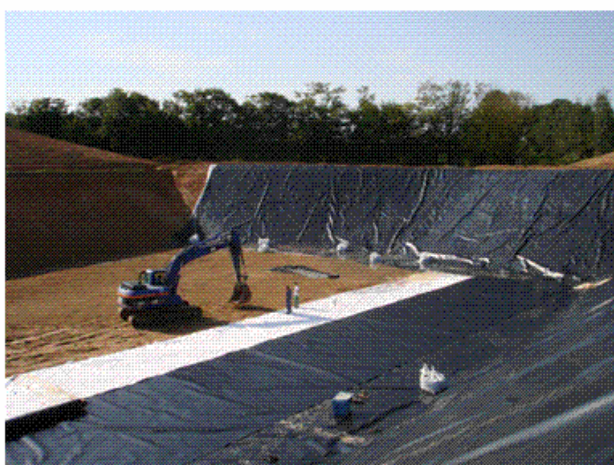
Pose de la géomembrane
