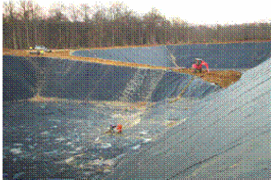
Décembre 2001 : Mise en place géomembrane
