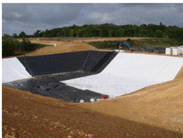
Pose du géotextile
